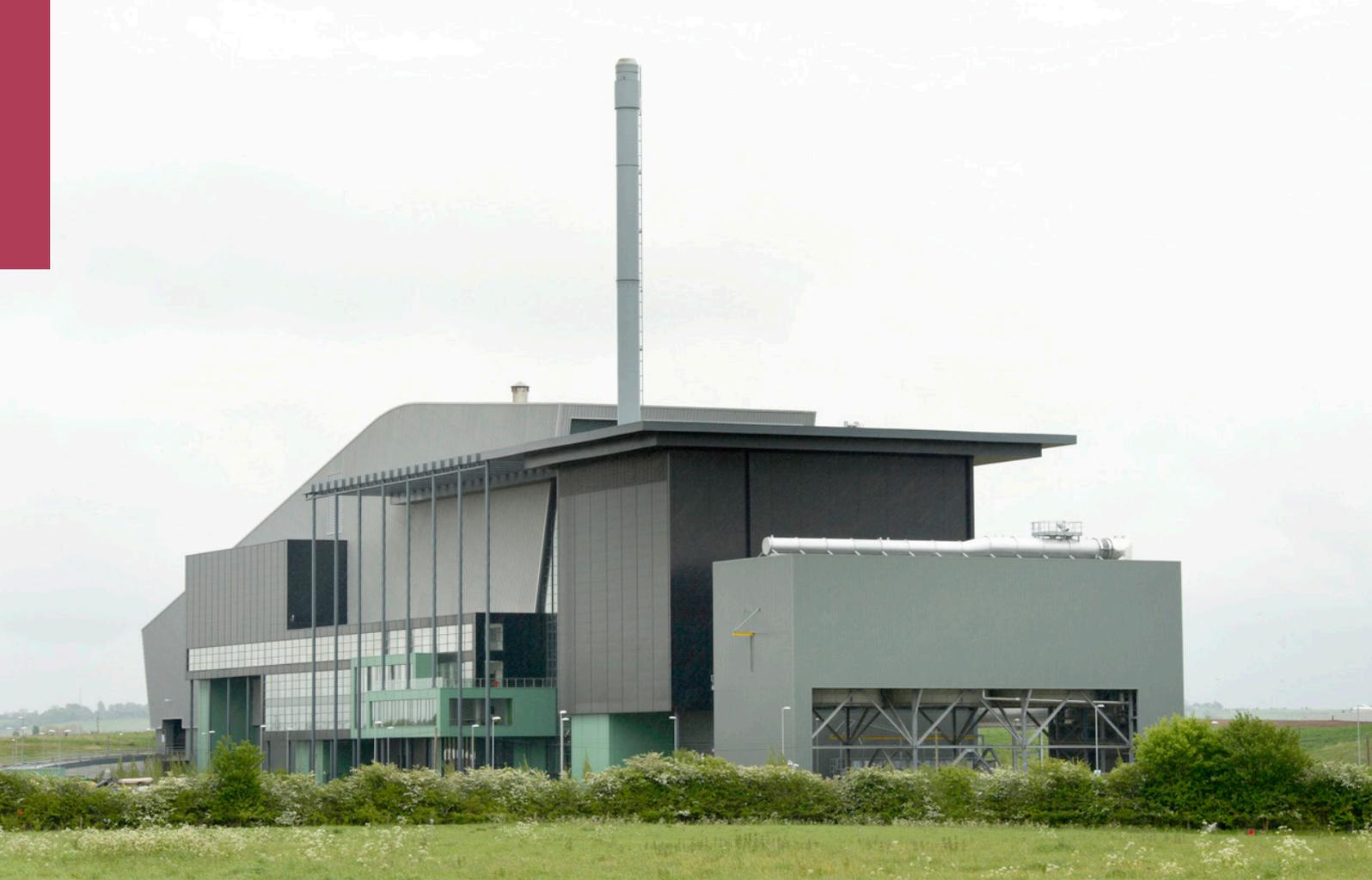
La incineradora que genera electricidad mediante desperdicios no reciclables y tiene capacidad para 150.000 toneladas.
